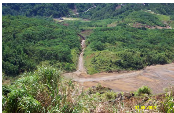
照片七 九份二山人工開挖導排渠道(2004.8.30)
