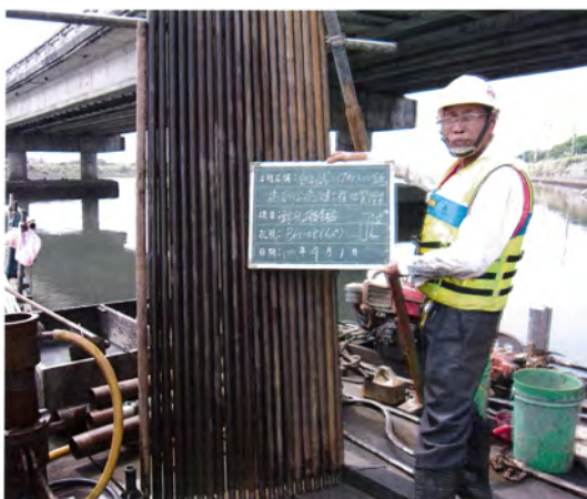
圖四 台二線河中鑽探
