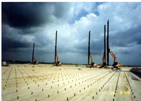
泰國國際機場施作 PVD 地質改良
