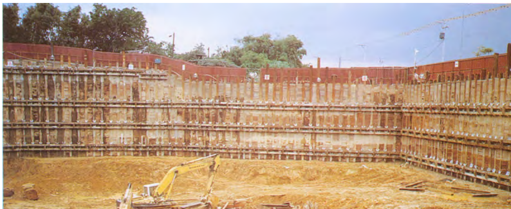
桃園都市生活大廈背拉地錨工程(民國 80 年)
