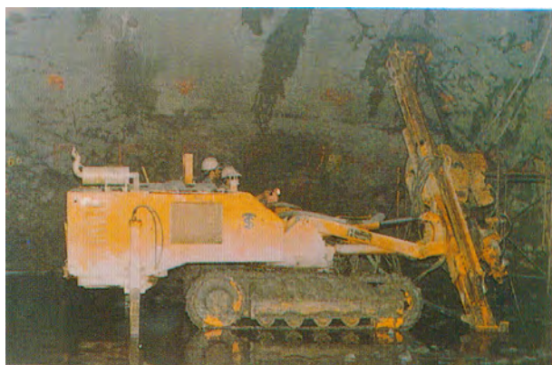
向上型岩錨工程(民國 75 年)
