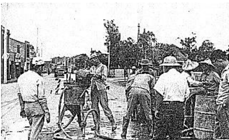
照片八 jetting & grouting 工法之波浪型路面改善（約民國 51 年）
