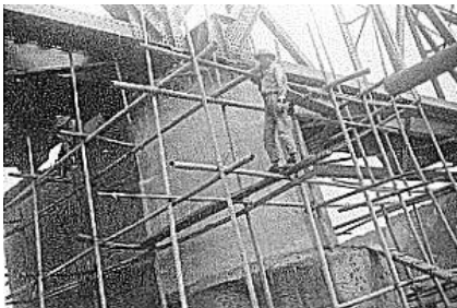
照片七 台鐵舊山線鐵橋墩柱噴漿加鋪網補強（約民國 53 年）
