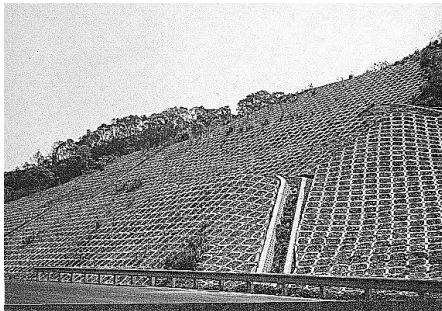
照片十五 北二高預鑄混凝土格框加綠化工程（約民國 81 年）
