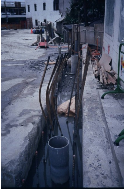
照片八 壁中井預埋管
