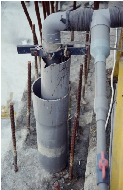
照片九 壁中井完成圖
