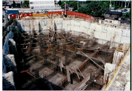
照片十 花蓮無支撐開挖案例
