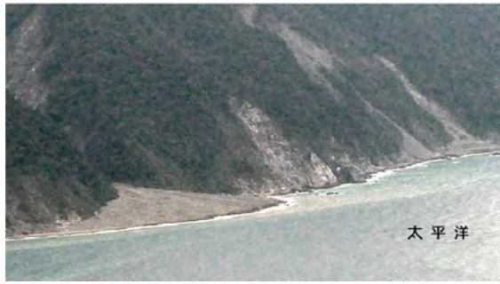
圖十四 2010.10.21台灣東海岸蘇花公路112K-116K 路段坍方土石墜落於崖底(洪如江攝, 2011.2.16)
