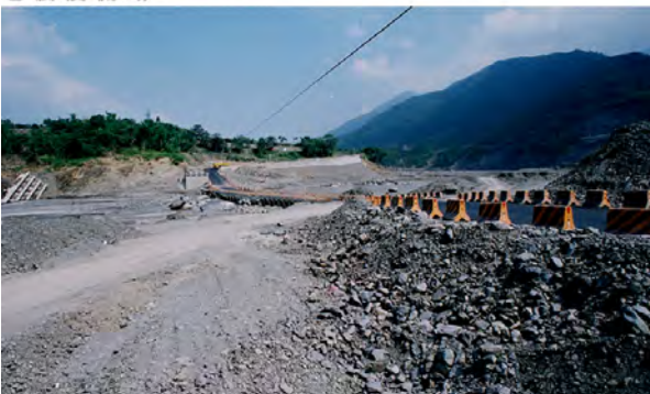
圖二十四 莫拉克颱風豪雨所引發的洪水及土石流造成許多橋樑斷落，便道改走河床(洪如江攝)
