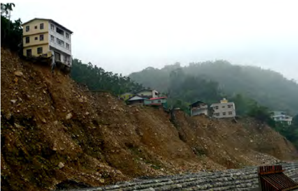
圖三十一 新山村在莫拉克颱風暴雨風災中，臨河房屋及道路皆坍塌只剩下搖搖欲墜陳有蘭溪中，只剩搖搖欲墜的後排屋(洪如江攝)
