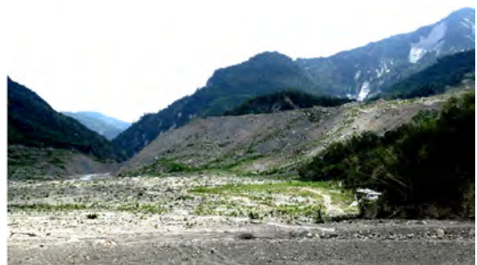
圖四十二 莫拉克颱風豪雨災後，小林村災區崩塌堆
