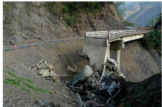
圖二十七 莫拉克颱風豪雨之洪水沖毀許多橋樑，使許多山地部落成為孤島 (洪如江攝)
