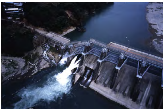
圖四十五 石岡壩因斷層錯動而破壞(連永旺攝)
