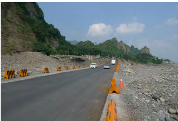
圖二十二 莫拉克颱風豪雨導致許多橋樑受洪水沖走，在河床構築便道(洪如江攝)
