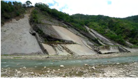
圖三十六 台21線公路，沿旗山溪谷岸順向坡開挖，在莫拉克颱風豪雨侵襲下，全面崩滑(洪如江攝)
