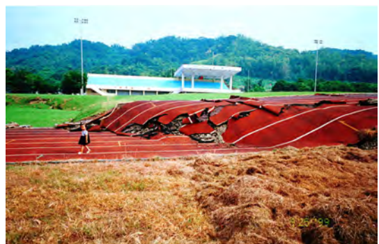
圖四十三 921大地震，光復國中操場的逆衝斷層與小小勘災者(洪如江攝)
