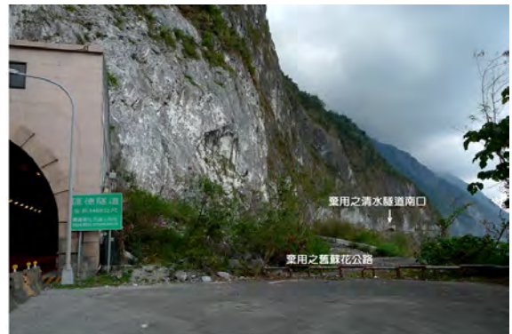
圖十 由滙德隧南口北望蘇花公路與舊清水隧道南口
