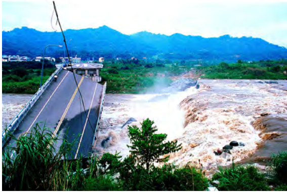
圖四十四 車籠埔斷層在大甲溪河床隆起,埤豐橋塌落中(洪如江攝)
