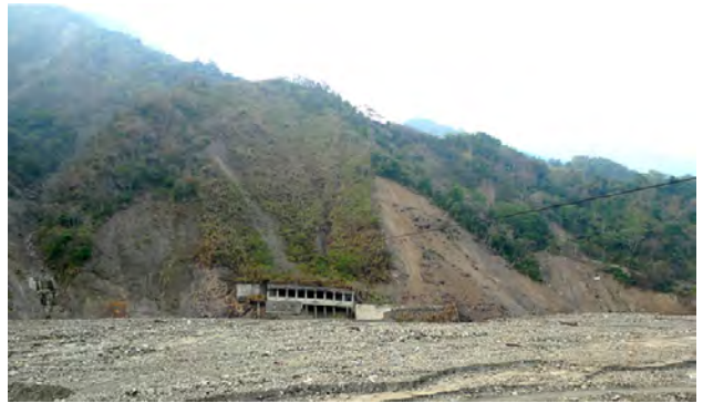
圖三十五 在莫拉克颱風暴雨災變，陳有蘭溪上游段公路全面崩塌(洪如江攝)
