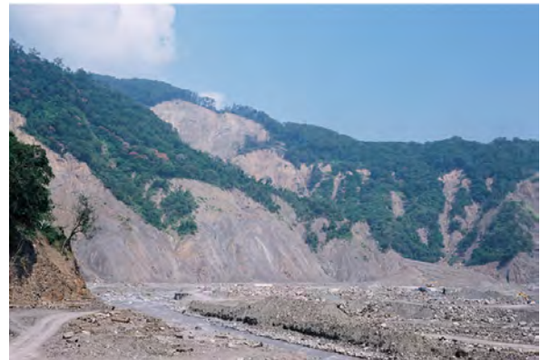
圖十七 莫拉克颱風災後, 寶來地區的荖濃溪岸崩塌, 溪谷擴張變寬(洪如江攝)
