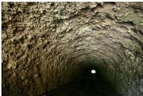
照片二 自立性良好，不需襯砌之礫岩隧道
