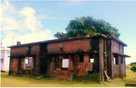
圖十八 氣象站後方的紅磚建物原為舊氣象站主體建物，爾後損毀，之後以現今白色建物(圖後)取代之(丁禕 攝)
