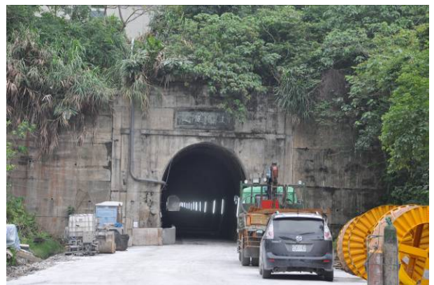
圖十二 北迴鐵路舊鼓音隧道
