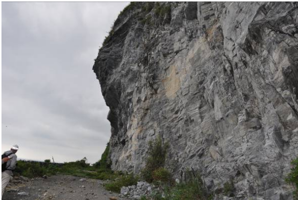
圖十八 大理岩邊坡節理發達，易有落石現象
