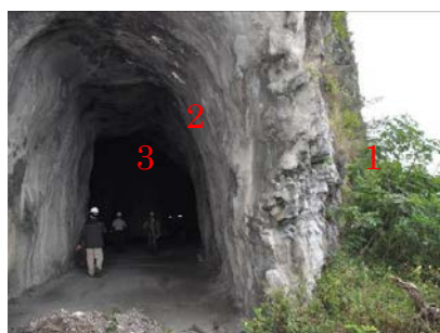
圖二十三 隧道路線變化圖 B 處 (向隧道內攝影)
