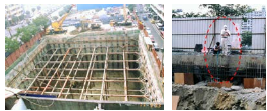
圖十一 臺中市某26層大廈卵礫石層基礎開挖與傾斜管監測
