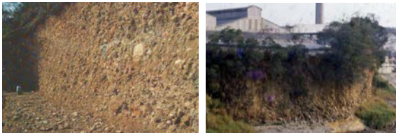
圖四 邊坡近乎垂直穩定情況
