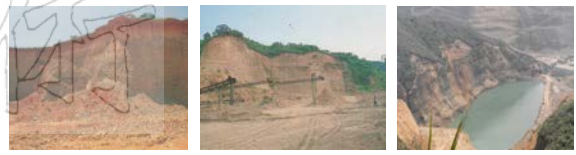
圖五 卵礫石層開採後殘留之陡峻邊坡
