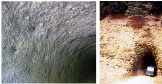
圖三 現地卵礫石層隧道與邊坡穩定的情況
