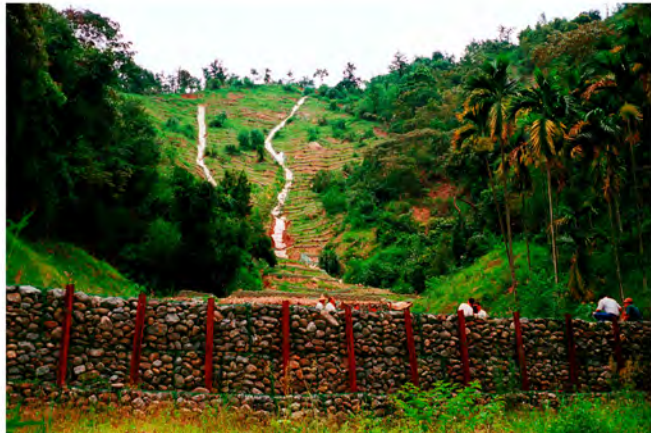
圖十一 埔里中心路土石流及崩場地源頭處理系統中之蛇籠攔砂壩具穩定之功能
