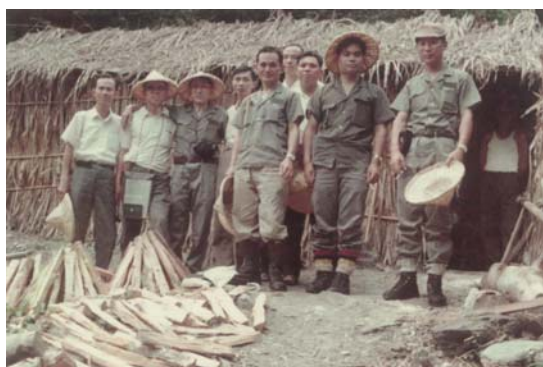
照片二 立霧溪水力開發計劃與日籍專家現場勘查
