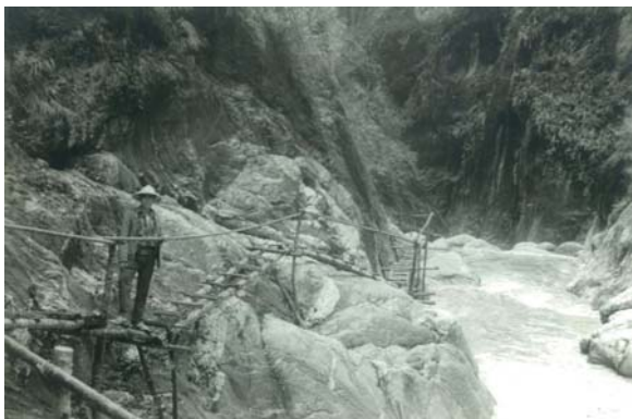
照片四 奇萊引水計劃現場地質調查所搭之臨時便橋
