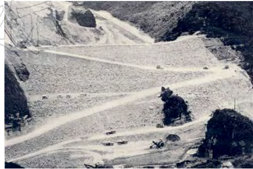
石門水庫上游擋水壩填築施工
