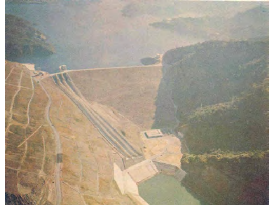
曾文水庫分階獨立瀉槽溢洪道
