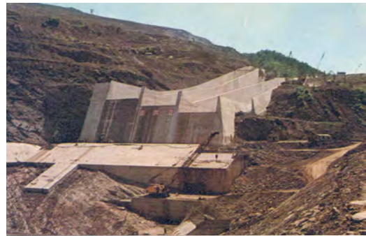
石門水庫上游擋水壩填築施工
