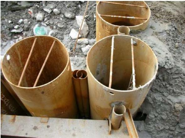
照片十三 案例C鋼管樁勾槽銜接情形
