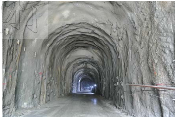
圖十 屏遮那隧道支撐完工貌
