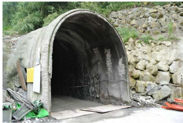
圖八 屏遮那隧道西洞口之假洞情形
