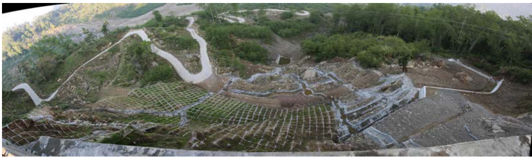
圖二十四 二萬坪崩塌區(孫漢豪先生提供)
