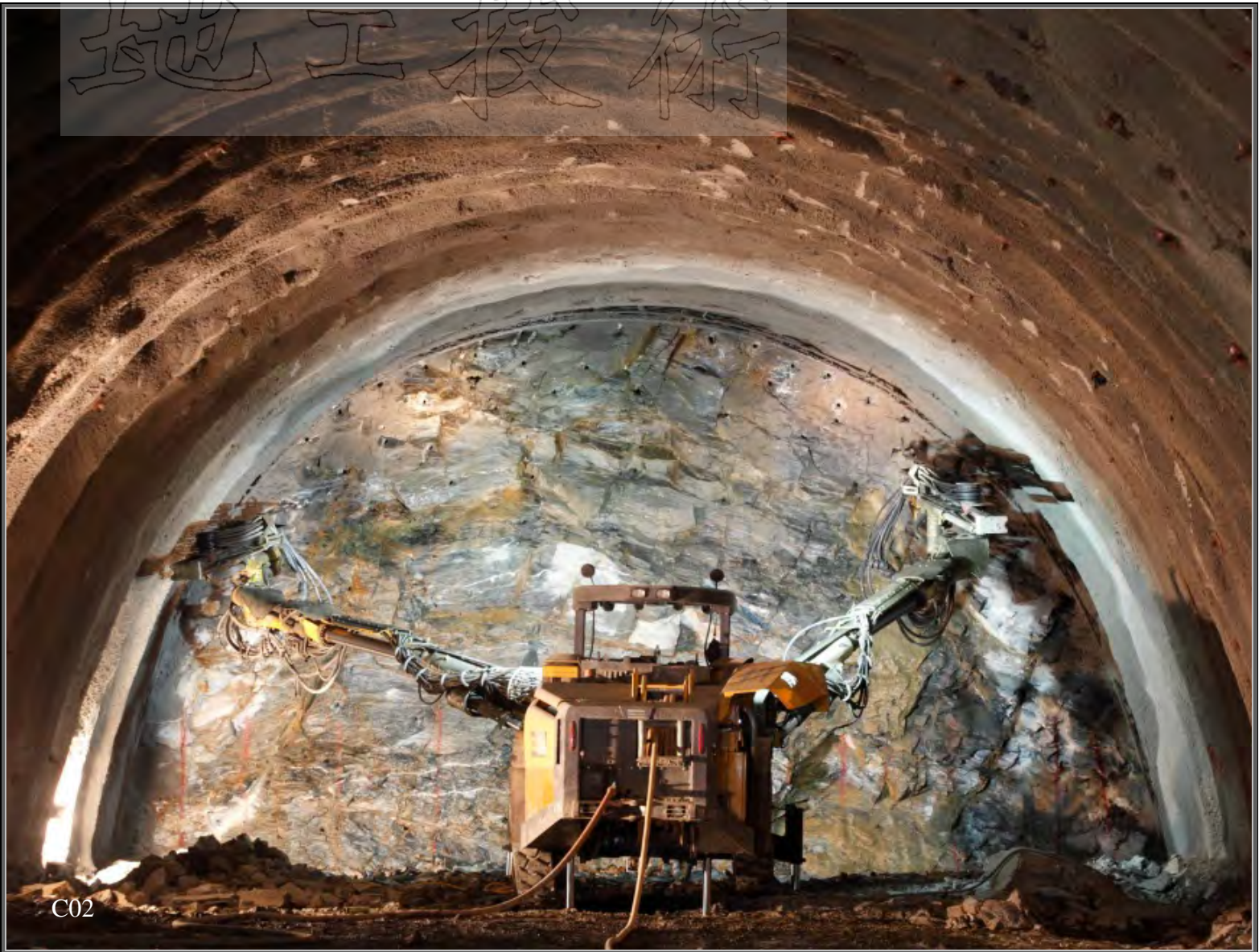
觀音及谷風隧道沿線出露地層均屬中央山脈東翼地質區大南澳片岩，主要岩性為黑色片岩、綠色片岩、矽質片岩及變質石灰岩（大理岩），本照片為觀音隧道北口南下線，工作面出露的是矽質片岩，鑽堡機則正在施鑽開炸孔。
