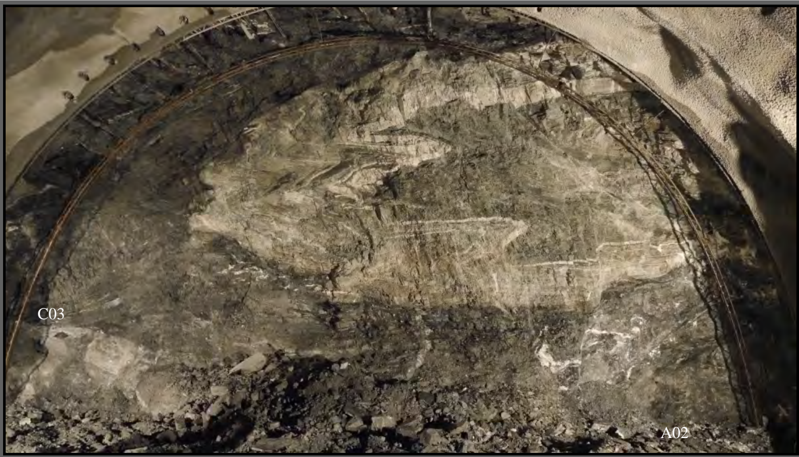
谷風隧道 NS3(A01)及觀音隧道 SS8(A02)鑽掘穿越斷層破碎帶、剪裂帶及湧水路段，施工困難度高，二張照片中的褶皺扭曲破碎(A01 為砂質片岩、A02 為黑色片岩夾砂質片岩)顯示出地質多變正對工程人員進行嚴峻的挑戰。
