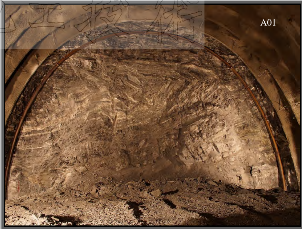
谷風隧道 NS3(A01)及觀音隧道 SS8(A02)鑽掘穿越斷層破碎帶、剪裂帶及湧水路段，施工困難度高，二張照片中的褶皺扭曲破碎(A01 為砂質片岩、A02 為黑色片岩夾砂質片岩)顯示出地質多變正對工程人員進行嚴峻的挑戰。
