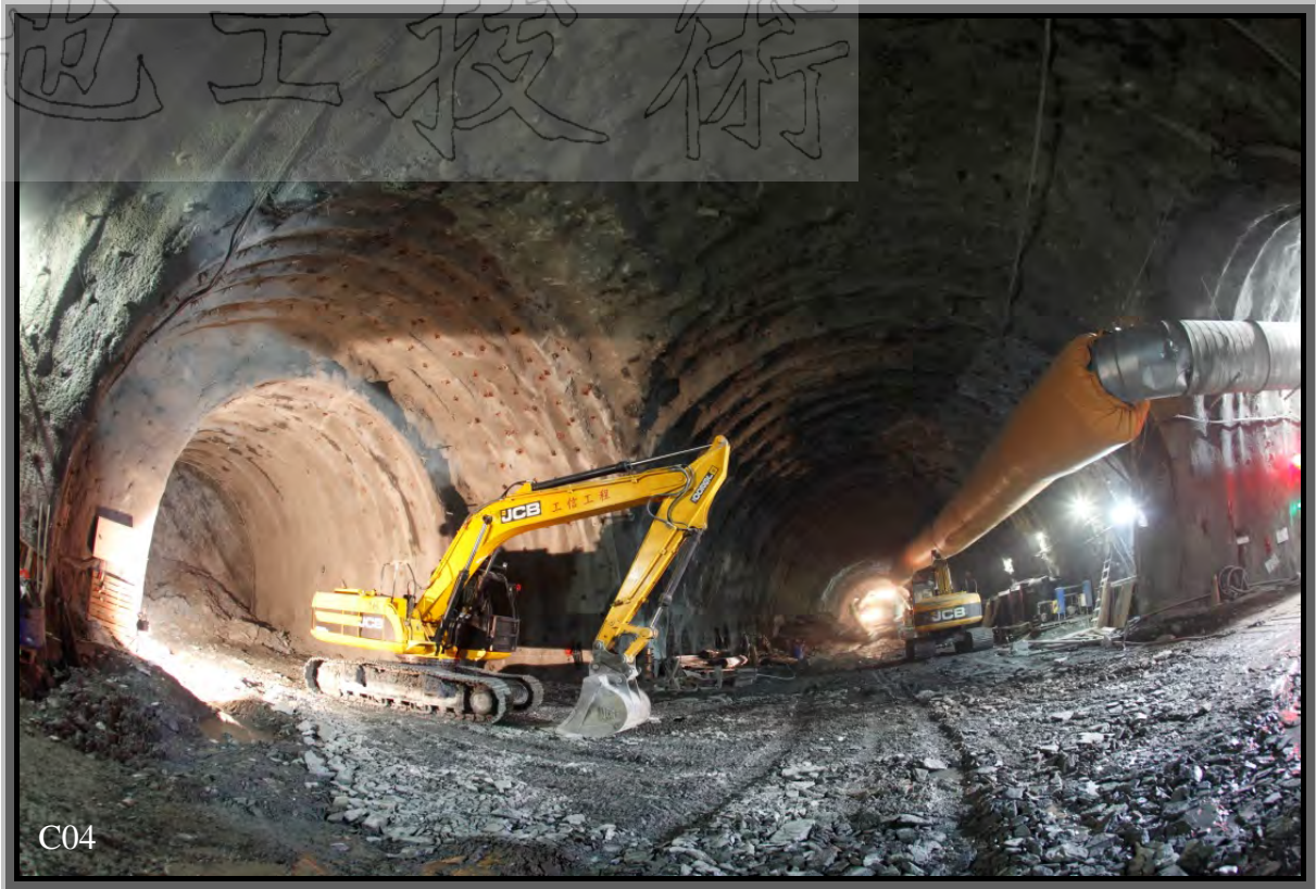
考量行車安全，主隧道南下線與北上線每隔 350 公尺設置一處人行橫坑，每隔 1400 公尺設置一處車行橫坑，並設置多處通風橫坑，連通南下線與北上線隧道。C04 為觀音隧道 NN3 工作面北上線與車行橫坑交叉處；C05 則為谷風隧道與通風橫坑交叉處。
