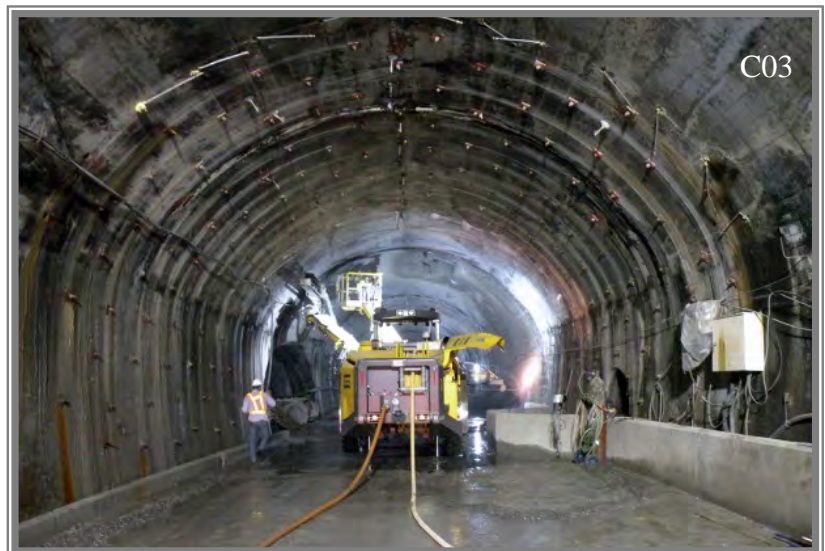
觀音及谷風隧道沿線出露地層均屬中央山脈東翼地質區大南澳片岩，主要岩性為黑色片岩、綠色片岩、矽質片岩及變質石灰岩（大理岩），本照片為觀音隧道北口南下線，工作面出露的是矽質片岩，鑽堡機則正在施鑽開炸孔。
