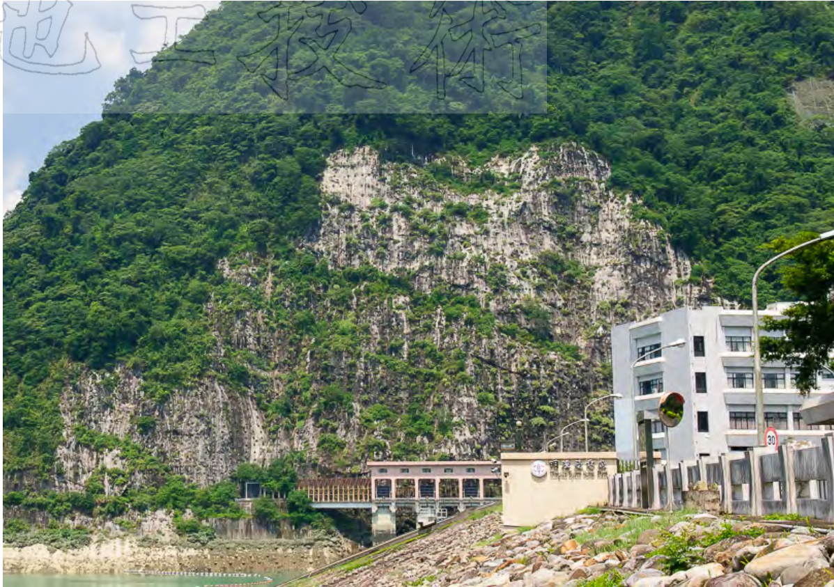
圖三 明潭電廠尾水出口照片
