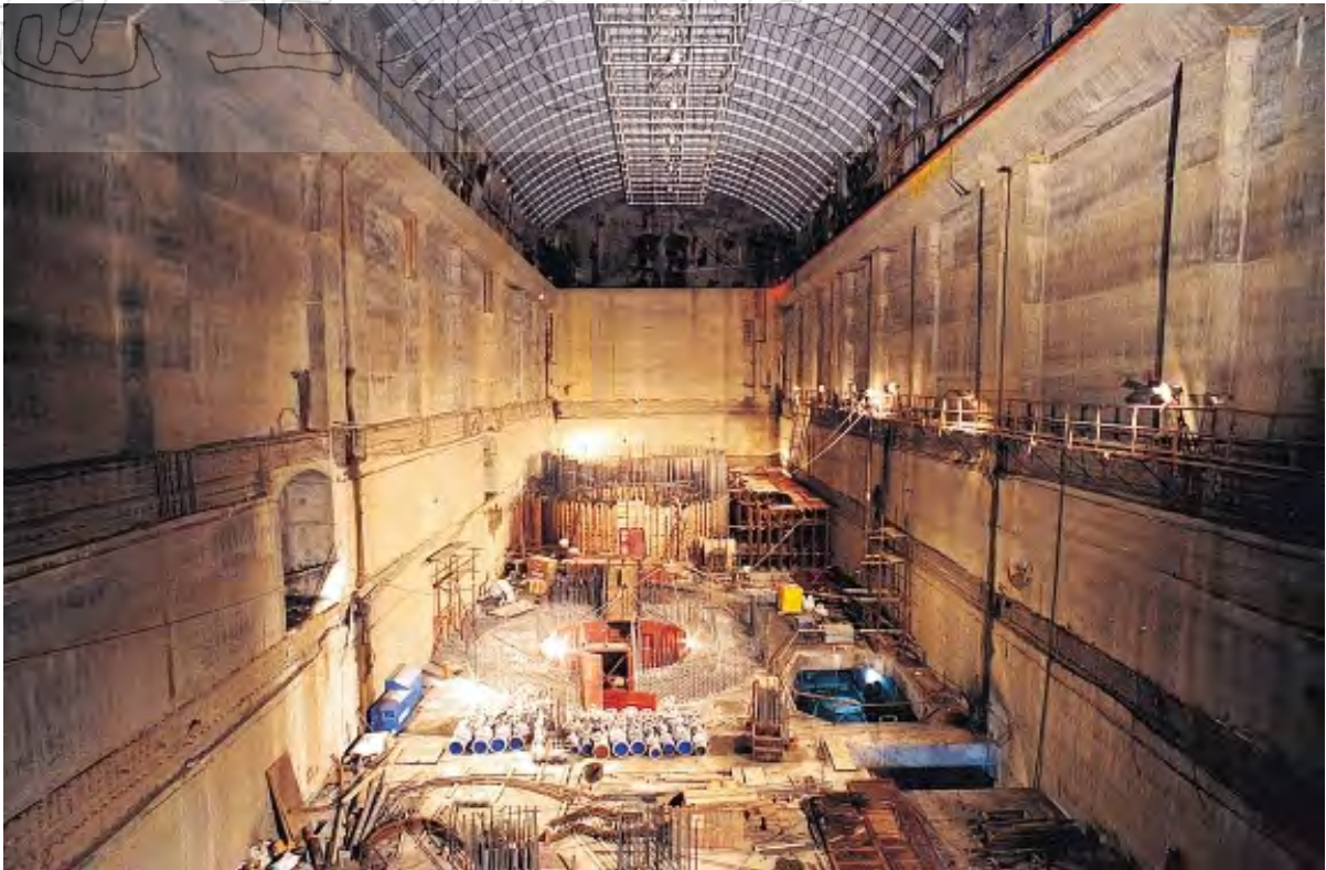
圖九 明潭地下廠房側牆襯砌施工情形
