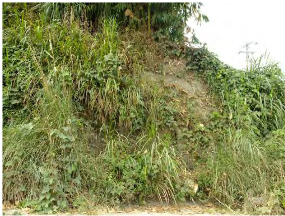
圖八 溢洪道下游左岸出露砂岩
