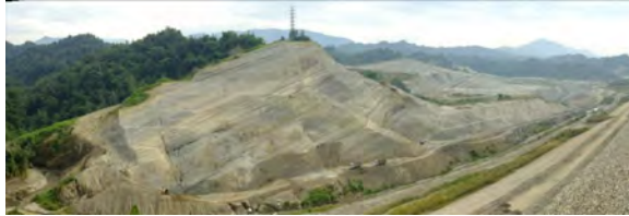
圖七 湖山水庫大壩上游邊坡開挖現況，砂岩、泥岩及其互層出露情形
