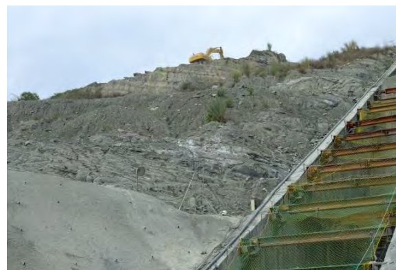
圖十 取水塔上邊坡出露砂岩及泥岩
