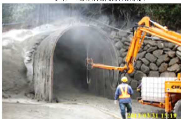
步驟三：噴佈鋼鐵纖維噴凝土
