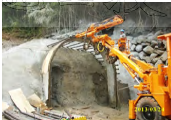
步驟一：管幕鋼管先撐保護頂拱
