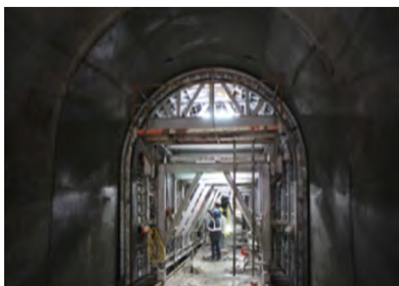
步驟三：澆置襯砌混凝土
