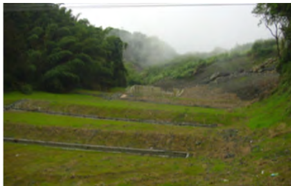
填土區回填及植生
