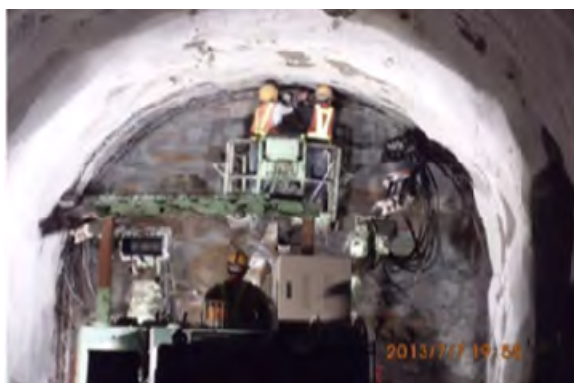
步驟二：組立桁型鋼支撐
