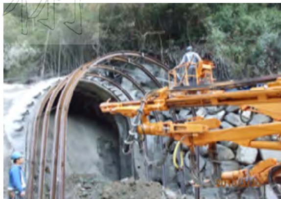
步驟二：假洞口段架設鋼支撐
