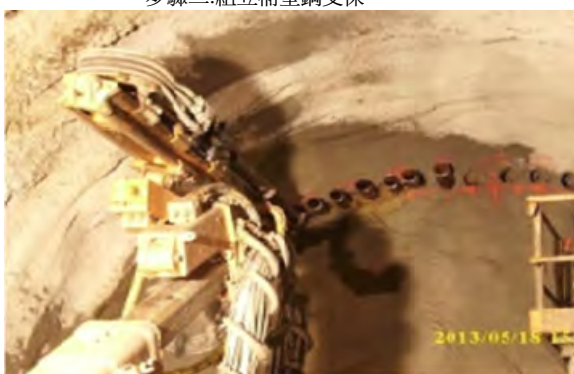
步驟四：鑽設管幕鋼管
