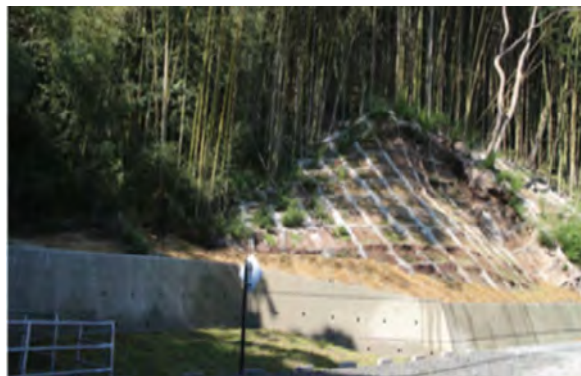
西洞口格梁護坡
