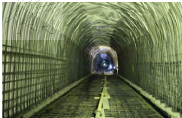
步驟二：組立襯砌鋼筋
