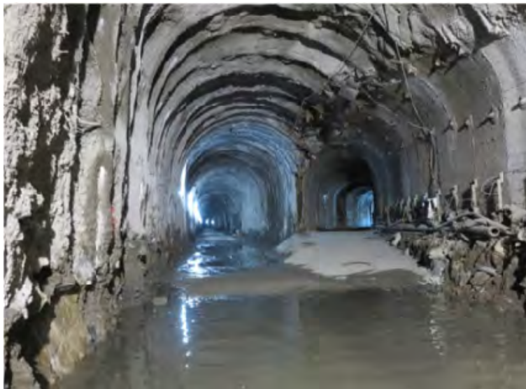
圖十 新建多林隧道匯接至既有結構良好的35號隧道
