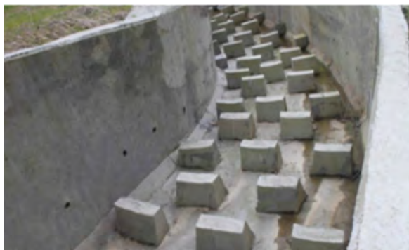
填土區齒墩型排水溝
