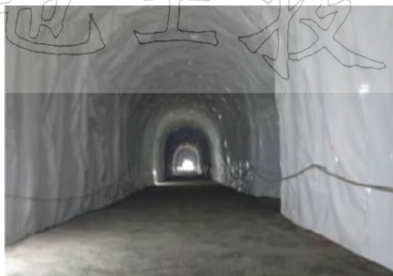
步驟一：鋪設全封閉式防水層
