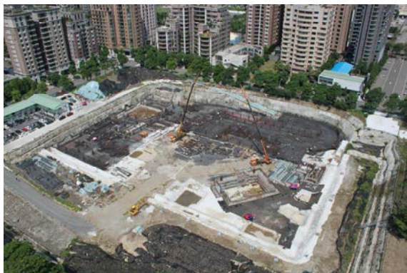
圖一 現場明挖及基礎底板分區施作
