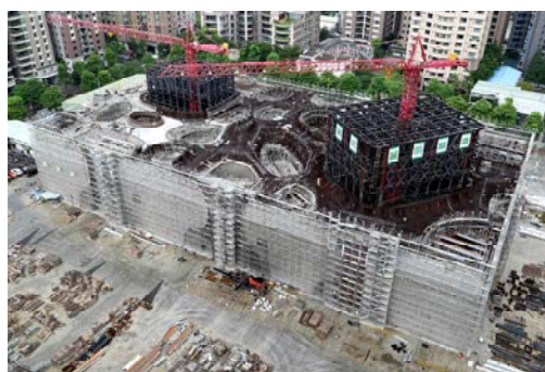
圖十一 曲牆施工全區鳥瞰
