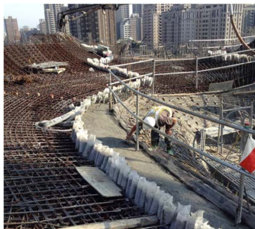
圖十 高流動混凝土澆置及隔離
