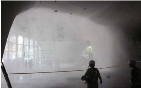
圖十四 水幕防火設備放水測試
