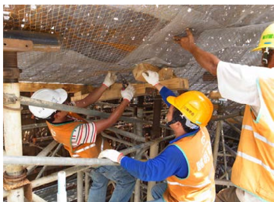
圖九 施工中鋪設金屬網外模
