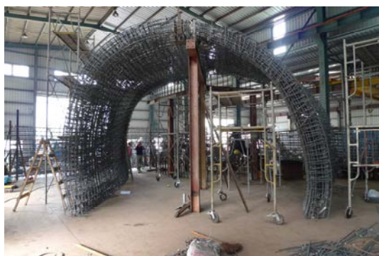
圖七 工廠曲牆單元組立
