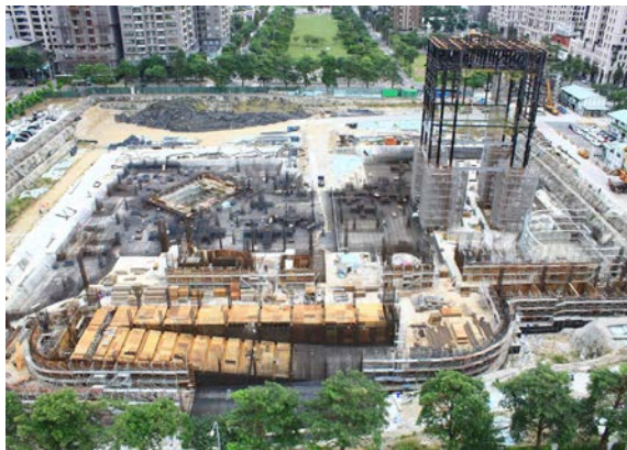
圖二 地下室開挖及結構體施工
