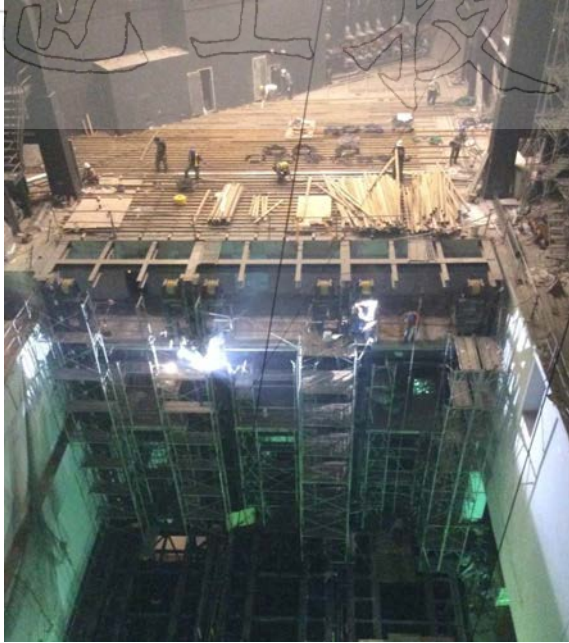
圖十三 大劇院舞台升降平台及地板施工
