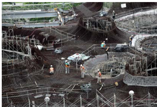
圖八 現場曲牆鋼筋綁紮
