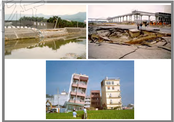
投影片六 集集(921)地震液化破壞(一)
