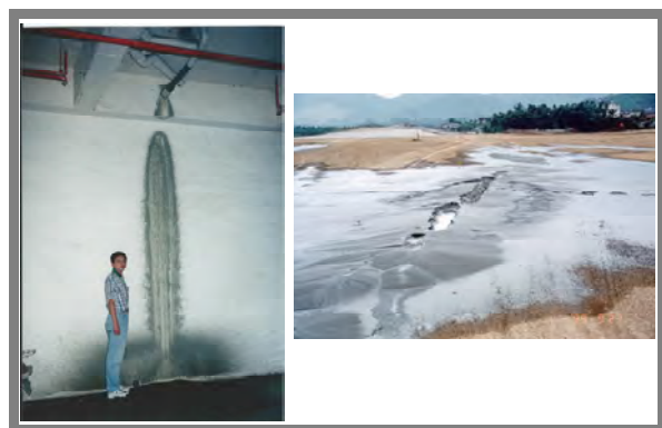
投影片十 集集(921)地震液化破壞(三)
