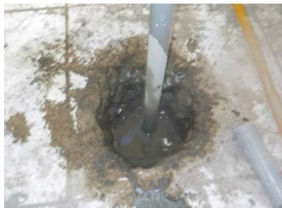
圖九 填充灌漿施工情形
