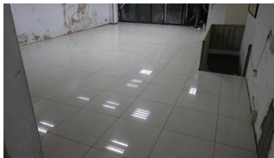
圖十 填充灌漿施工後地坪修復情形
