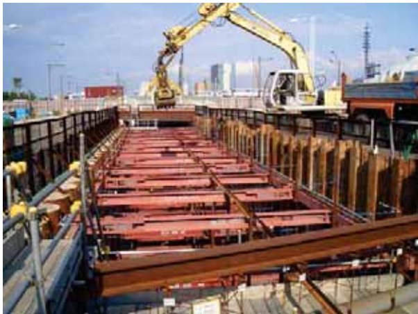
圖 12.7 擴建部份左側為新建鋼管樁；右側為鋼版樁
