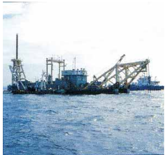
圖 9.3 撒砂船施工之情形
