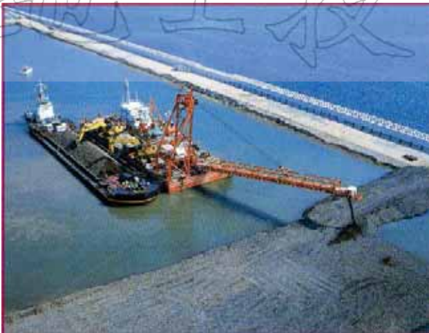
圖 9.11 大型平底運砂船及輸砂設備
