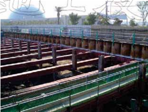
圖 12.6 鋼管樁開挖支撐照片
