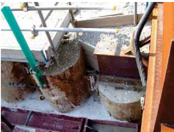
圖12.8 鋼管樁接合詳圖及灌漿止水處理
