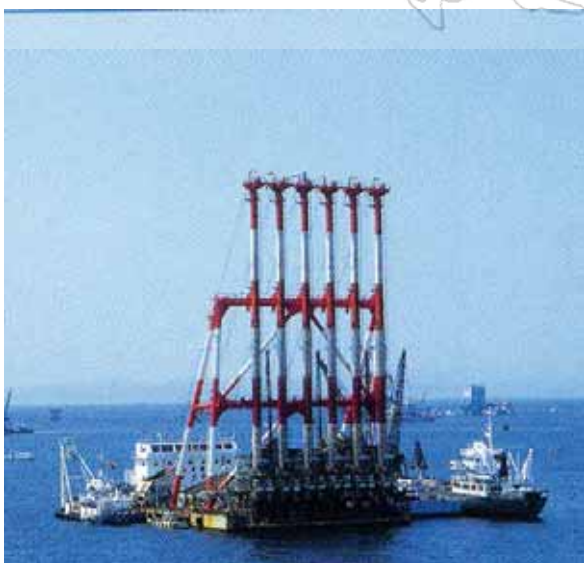
圖 9.4 打設砂樁之施工船
