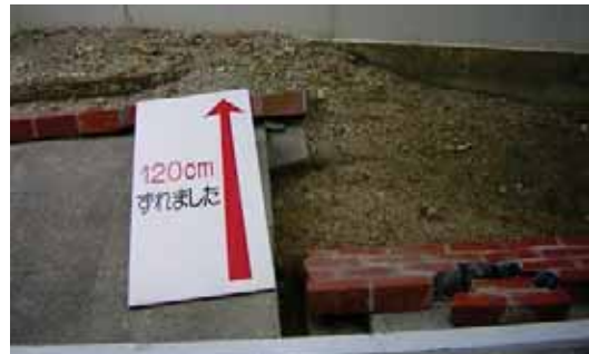
圖 9.23 因地表水平位移造成之花圃破壞
